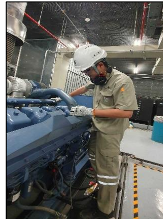
ภาพที่ 30 ตรวจสอบระบบท่อไอเสียจากห้องเครื่องกำเนิดไฟฟ้า
